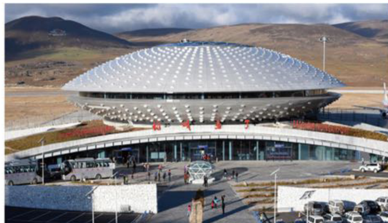
四川稻城亚丁机场航站楼工程幕墙装饰工程
